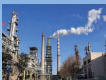
脱硫脱硝装置区
