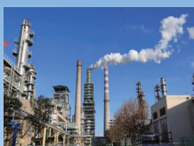
脱硫脱硝装置区
