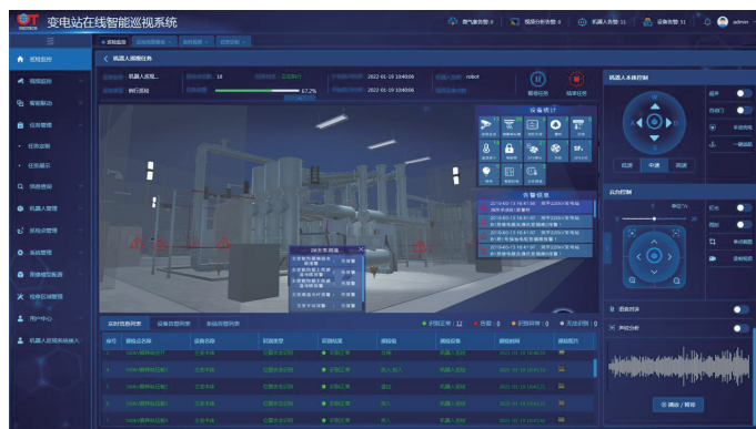
图18 主变三维巡视
