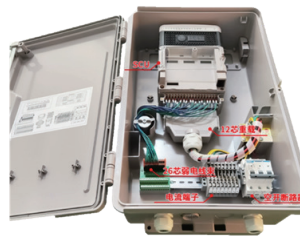
SCU台区智能融合终端箱体内部示意图
