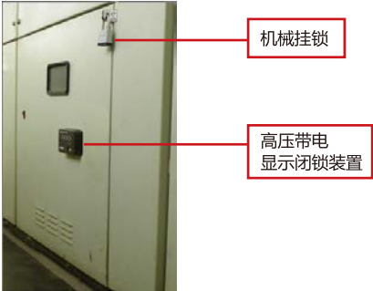
图 2 后柜门安装示意图
