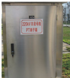
图3 改造后的端子箱平面锁
