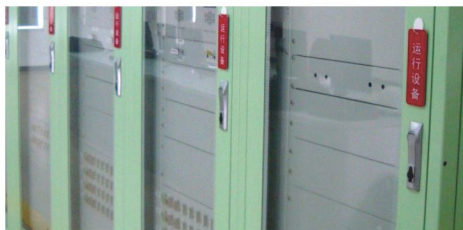
图5 改造后的屏柜门连杆锁
