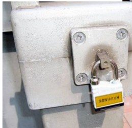
图6 DNBS-3U闭锁操作机构
