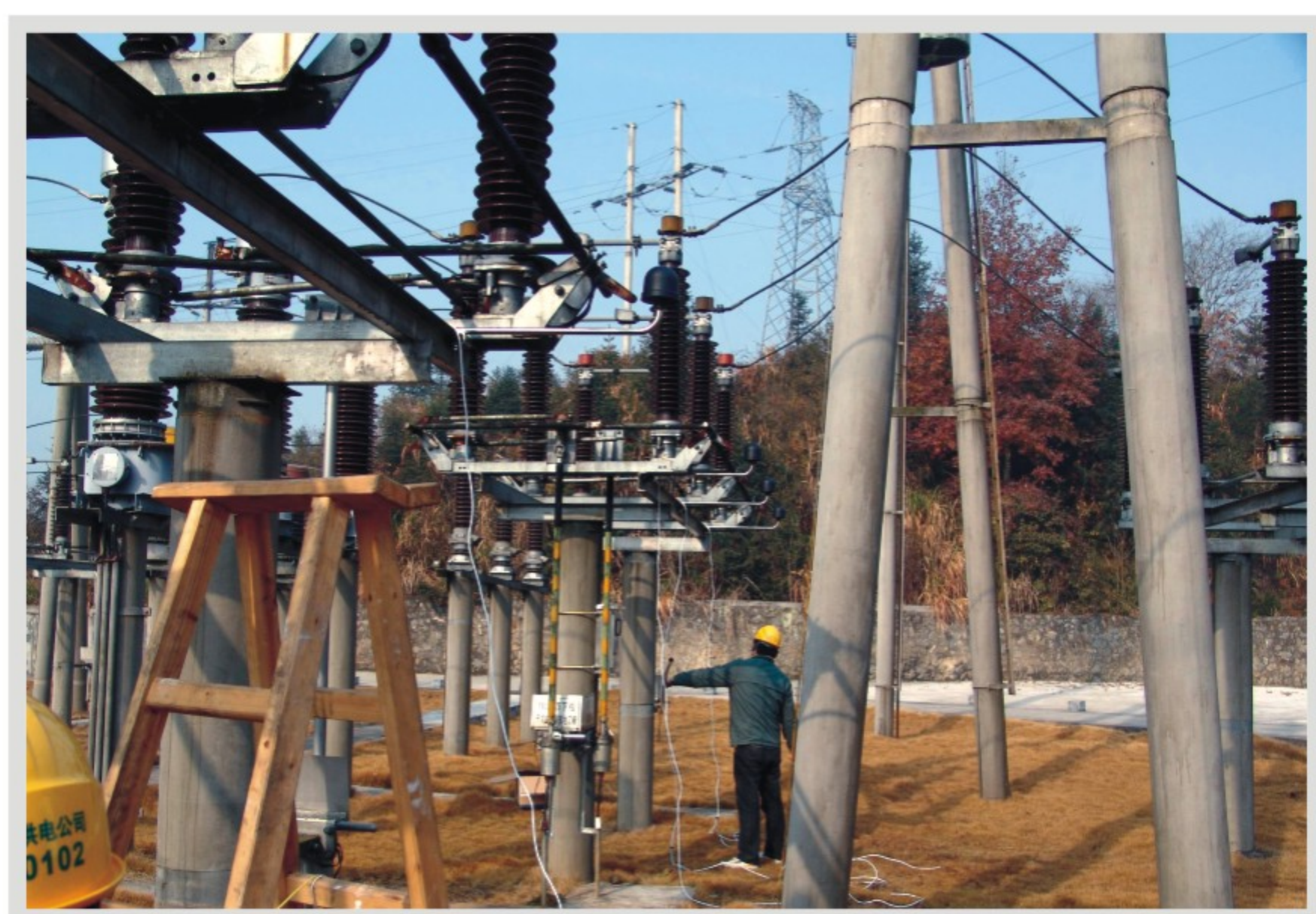
图6 该变电站不停电安装现场
